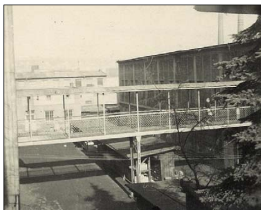
Spojovací lávka mezi hlavní a dvorní budovou, asi 1942
