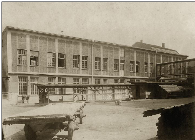
Druhá budova křídárny, sušárny a kartonáže, v předu sklady, 1912
